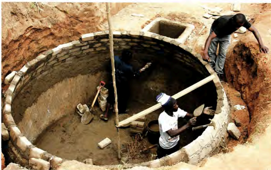
Bau einer Biogasanlage.
